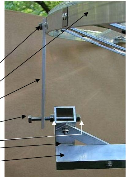
Au centre, la barre centrale est tenue par une petite pièce d'aluminium **R13**, dans laquelle une vis M8 x 80 n'est pas fixée. La vis est fixée au support en rotation (**RS6**) et sert aussi d'axe de rotation lorsque les ajustements saisonniers se font.
